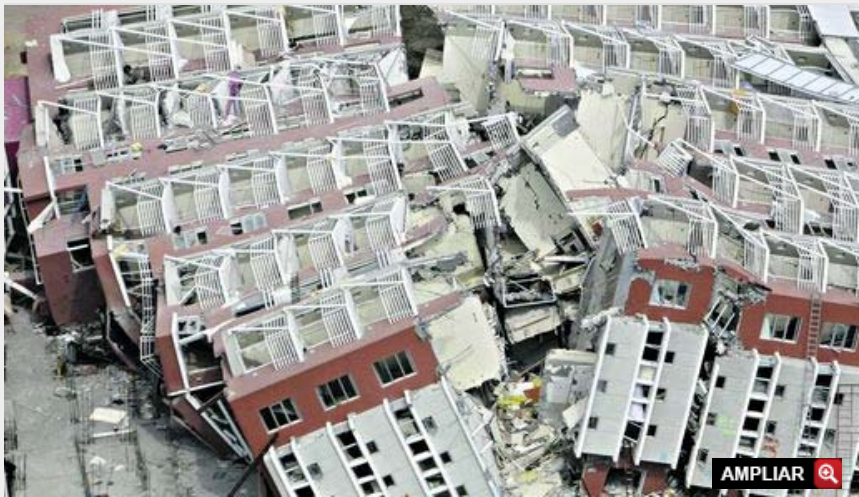
COLAPSADO. UN EDIFICIO DERRUMBADO Y PARTIDO EN VARIOS PEDAZOS, VÍCTIMA DEL SISMO EN CHILE DE FEBRERO.
